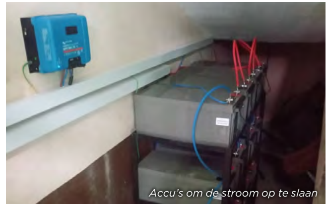
De technische installatie
